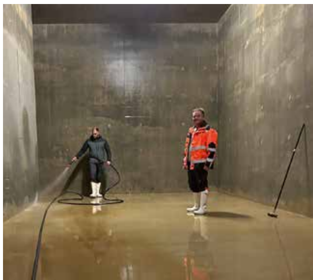
Le site de la Place, nettoyage du réservoir (photo P.-A. Genoud)
