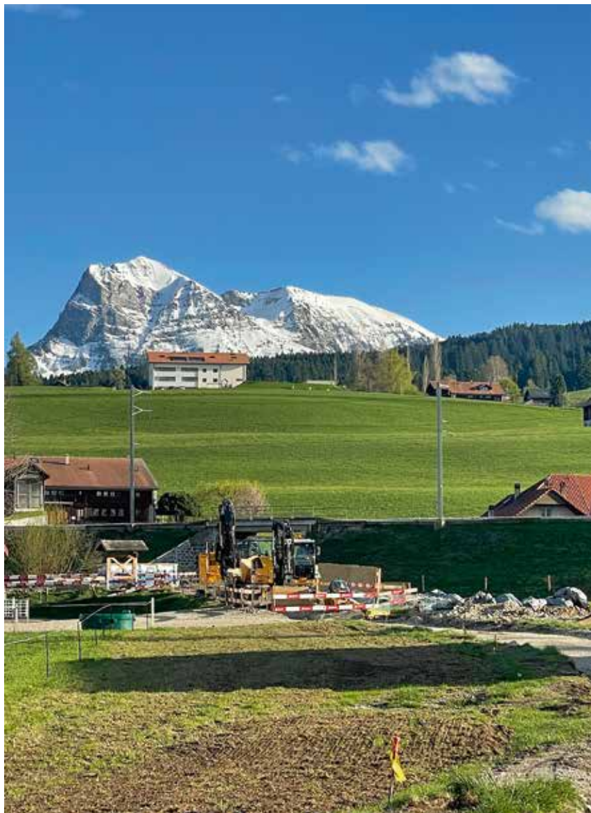
Les travaux de rénovation du réseau d'eau en cours à la route de la Chapelle (photo J.-B. Repond)
