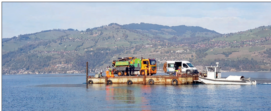
Curage d'une prise d'eau sur le lac de Thoune
