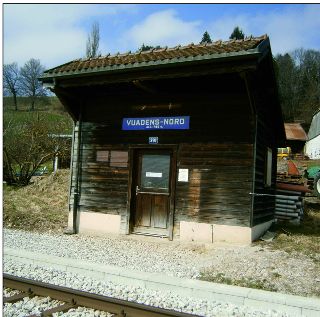
La halte de Vuadens-Nord va aussi être démolie
